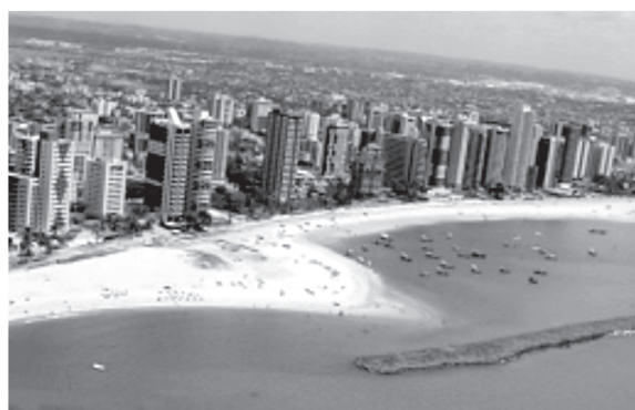
Figura 2 – Vista atual da área do quebra-mar da praia de Candeias, Jaboatão dos Guararapes – Pernambuco, sem o espigão perpendicular e com o engordamento da praia (Fonte: CPRH).
