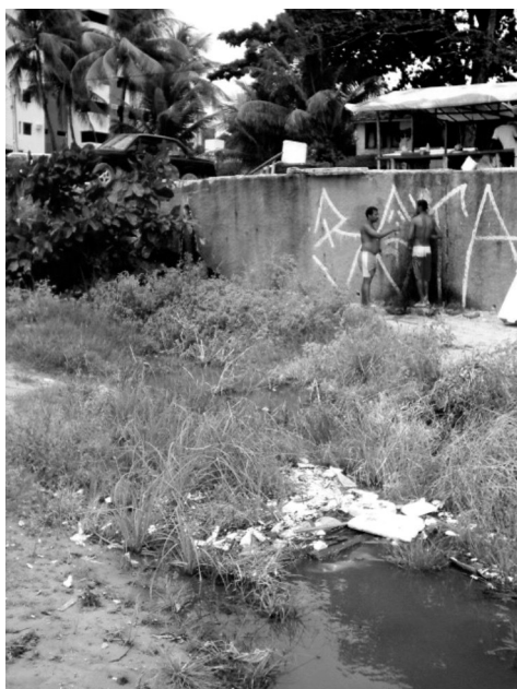
Figura 7 – Evidência de deficiência no sistema de saneamento básico em esgoto doméstico na Praia de Candeias, Jaboatão dos Guararapes – Pernambuco.
