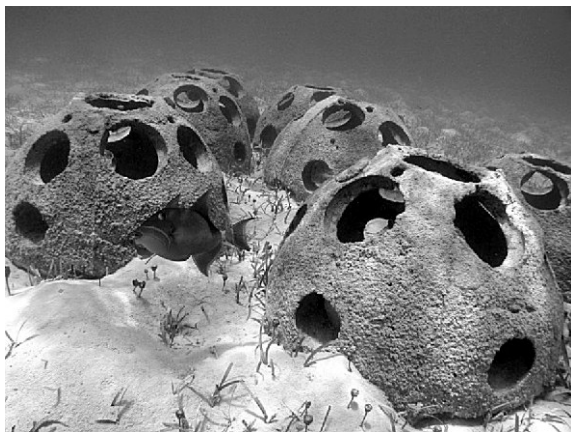
Figura 2 – Reef balls feitos em concreto estão entre as categorias de recifes artificiais pré-moldados mais utilizados no mundo (Fonte: Reef Ball Foundation, Inc.).
