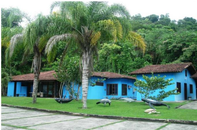
Figura 1: Sede e Alojamento da ESEC Tamoios em Mambucaba, Paraty/RJ
