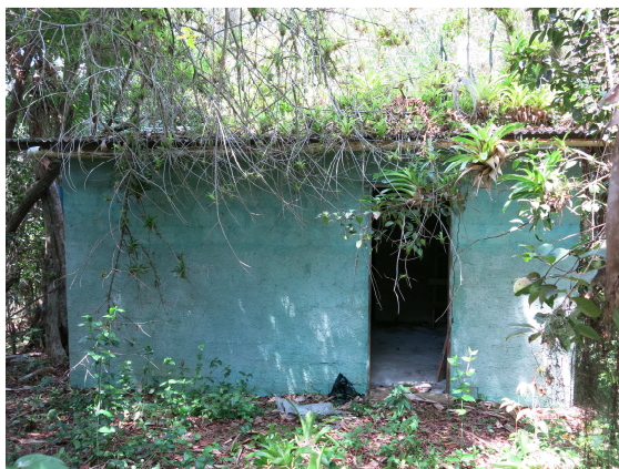
Figura 5: Edificação antes da demolição;
