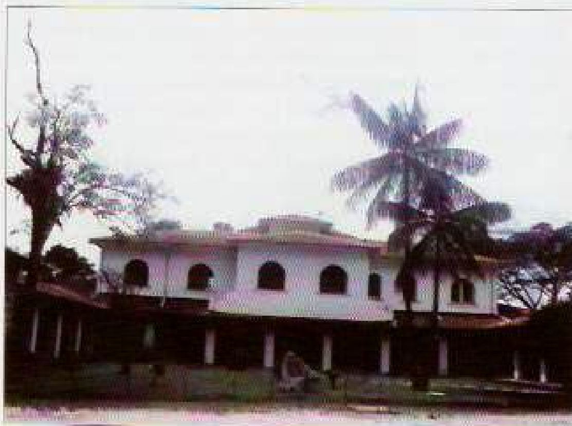
Figuras 43 e 44. Vista do edifício-sede do Parque Nacional do Itatiaia, atualmente constituindo o centro de visitantes do PNI. Fonte: Registro fotográfico feito por Raquel Portes em 2002.
