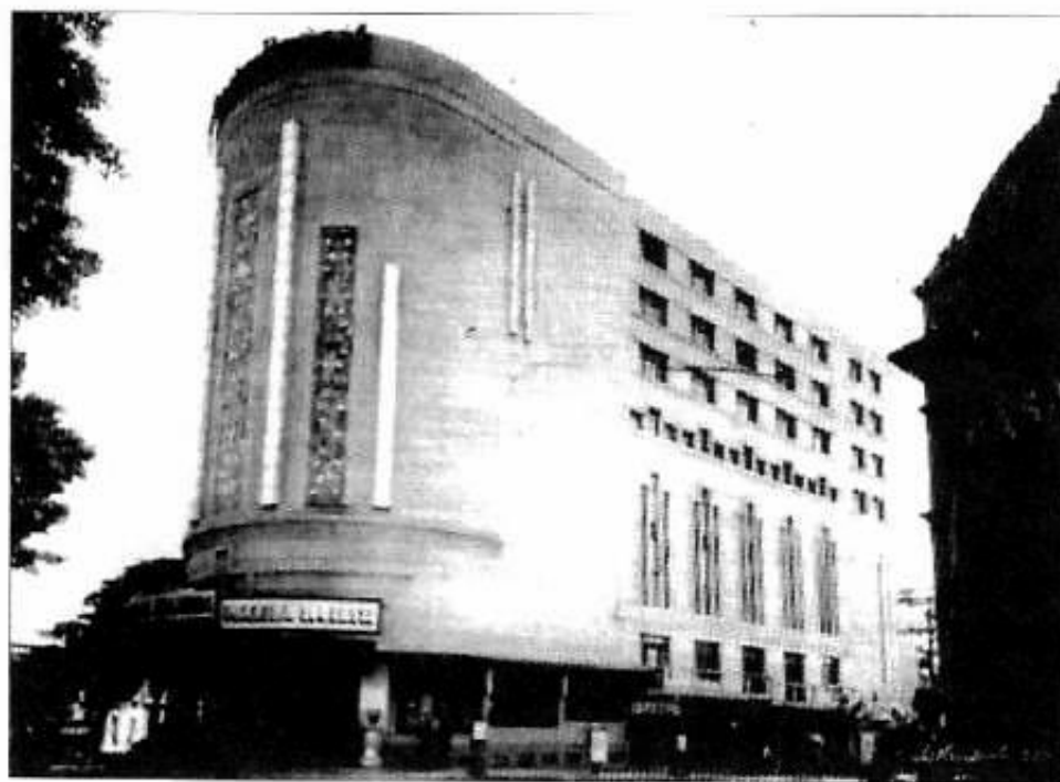
Figura 4. Edifício do Cine Brasil, projetado por Angelo Murgel em 1932. Fonte: CASTRIOTA, Leonardo. Arquitetura da Modernidade , p.156.
