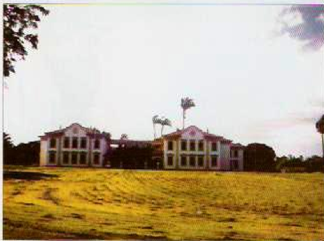
Figuras 41 e 42. Vista dos pavilhões 2 e 3 previsto para a instalação da Escola Nacional de Agronomia, hoje abrigando cursos de graduação da UFRRJ. Fonte: Registro fotográfico feito por Raquel Portes em 2002.
