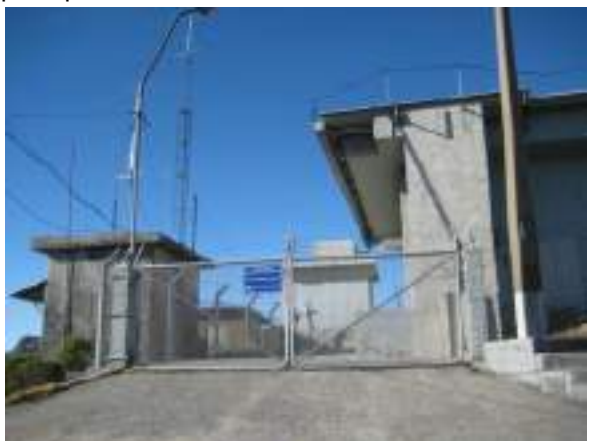
Figura 144: Infraestrutura na base da antena principal de Furnas. Foto: Yukie Kabashima
