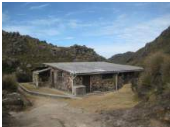
Figura 46: Abrigo Rebouças vista dos fundos para quem está chegando. Foto: Yukie Kabashima
