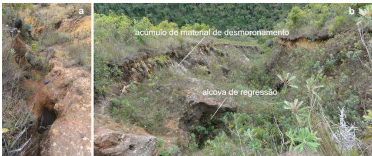
Figura 5.3 - a) Ponto 2 - sulcos e compactação dos solos na trilha da Travessia Rui Braga (Coordenadas UTM N0536701, E 7522510); b) Ponto 3 – sistema de voçorocas perpendicular à trilha da travessia Rui Braga, e paralelo à encosta (Coordenadas UTM N0 536493, E 7522542). (Fotografias: Júlia Pera).
