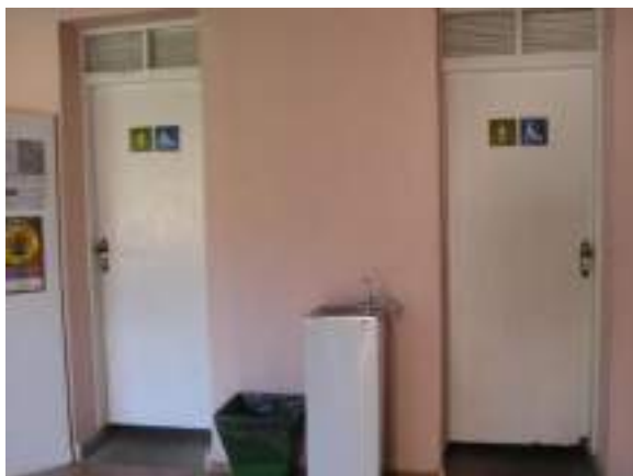
Figura 19: Lixeira na saída dos sanitários do segundo piso do Centro de Visitantes. Foto: Yukie Kabashima
