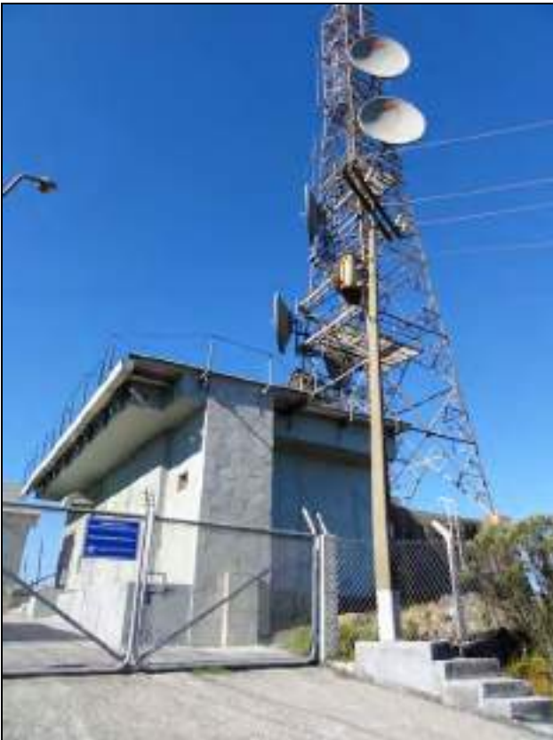
Figura 12 – Estação de Micro-Ondas de Furnas Centrais Elétrica localizada no interior do PNI. (Fotografia: Cristiane Gomes Barreto).
