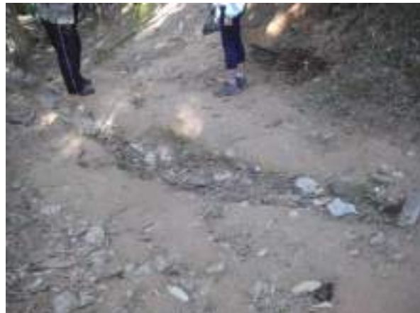
Figura 87: Vala de drenagem deteriorada na Trilha do Lago Azul. Foto: Yukie Kabashima
