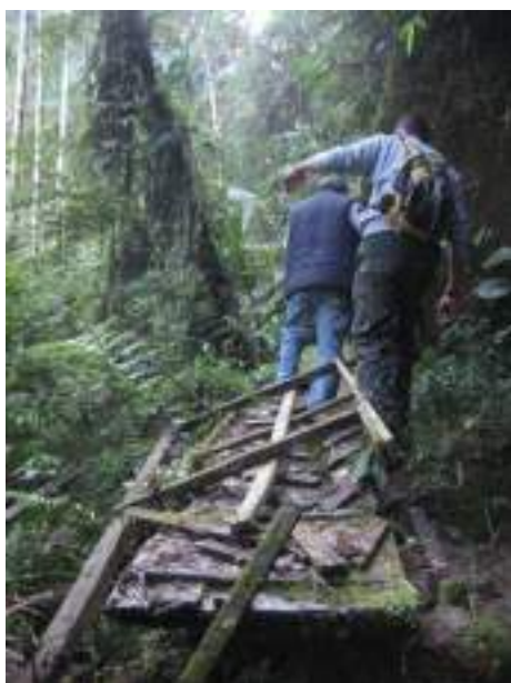
Figura 102: Passarela deteriorada na trilha para a Cachoeira do Itaporani. Foto: Yukie Kabashima
