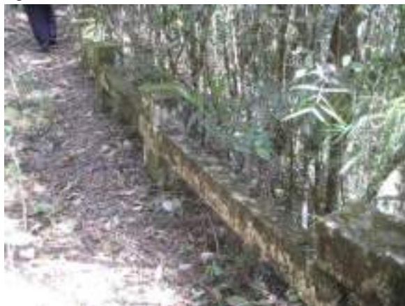
Figura 65: Estrutura de proteção em concreto espalhados pela antiga estrada de acesso à Água Branca. Foto: Yukie Kabashima
