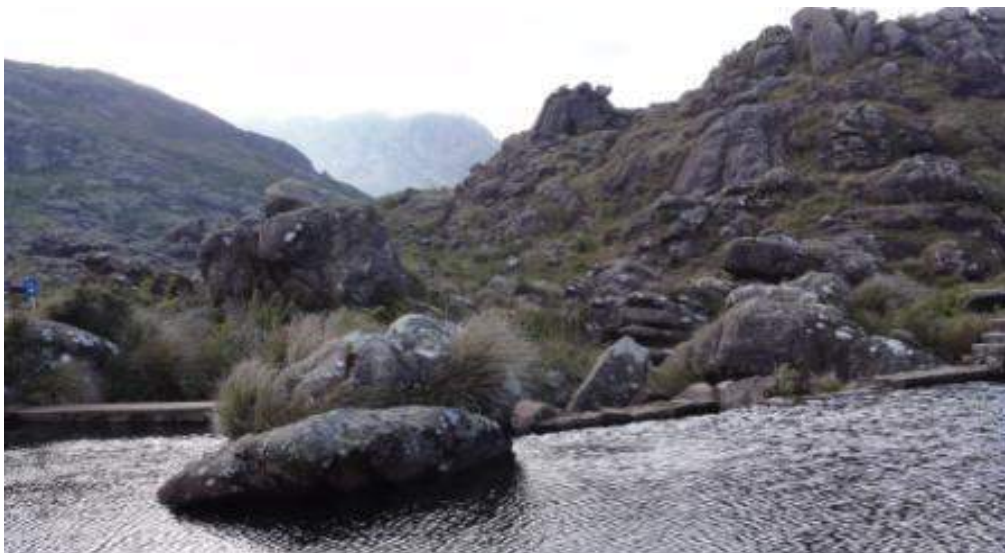
Figura 7.4 - Represa do Abrigo Rebouças (Coordenadas UTM N532990, E7524452). (Fotografia: Júlia Pera).
