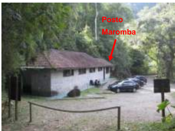
Figura 33: Edificação com o Posto Maromba. Foto: Yukie Kabashima
