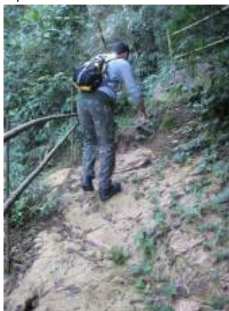
Figura 103: Piso com inclinação lateral acentuada na trilha para a Cachoeira do Itaporani. Foto: Yukie Kabashima
