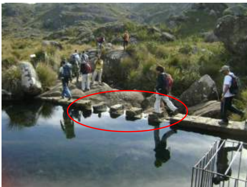
Figura 51: Intervenção na passagem da represa próximo ao Abrigo Rebouças. Foto: Edson F. Santiago
