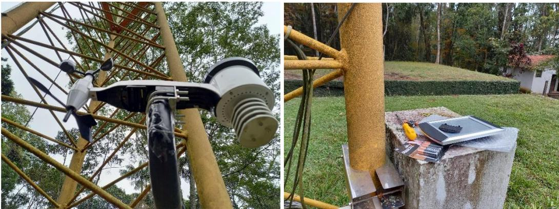
**Figura 2.** Manutenção e troca das baterias dos sensores e monitor LCD da estação ITWH1080.
