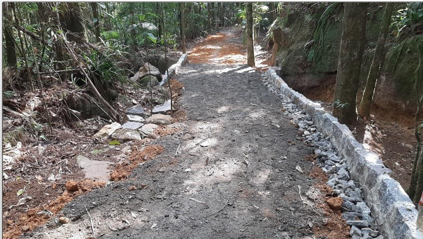
Obra-de-arte construída para drenagem de escoamento superficial sob a trilha.
