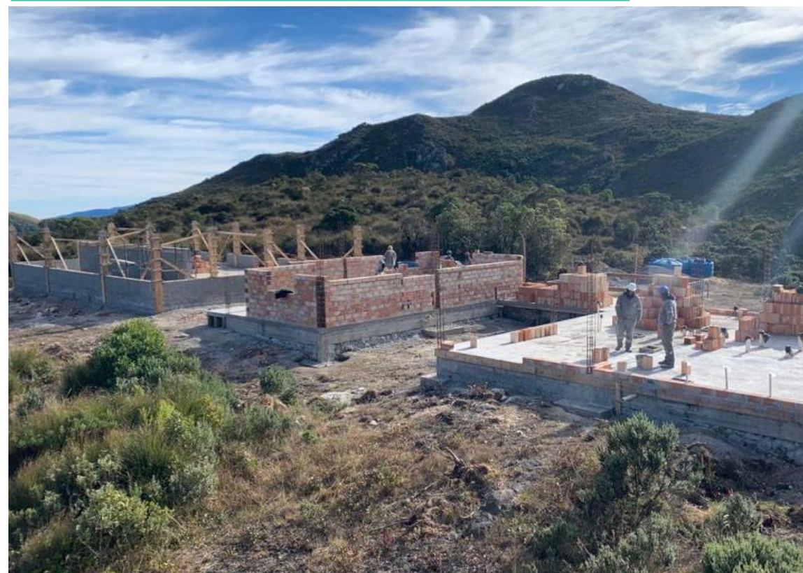
Construção de banheiros, cantina e área de refeição
