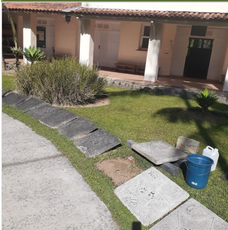
Fase 1 Limpeza das placas
