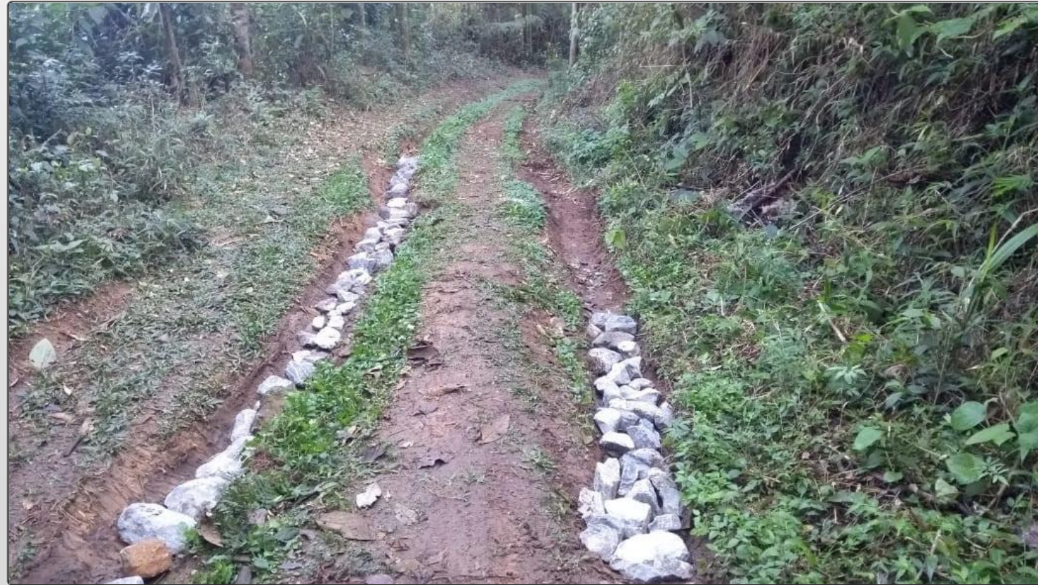
Preenchimento de sulcos erosivos para recuperação da travessia Ruy Braga.
