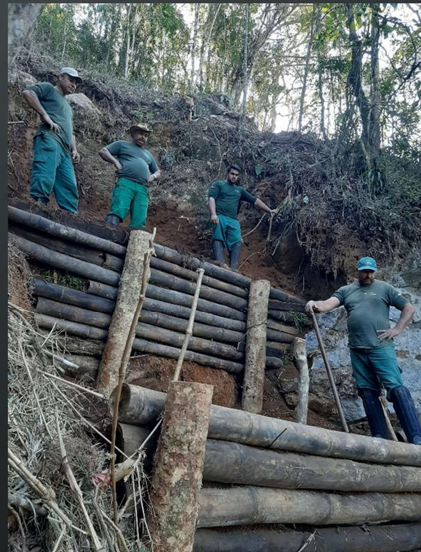
Imagem da contenção e recuperação de trecho onde houve desbarrancamento de parte do leito da antiga estrada. Tais intervenções foram realizadas pela **Equipe de Trilhas do PNI**, utilizando técnica de patamares, plantio de bambu e contenção com muro de pedras.
