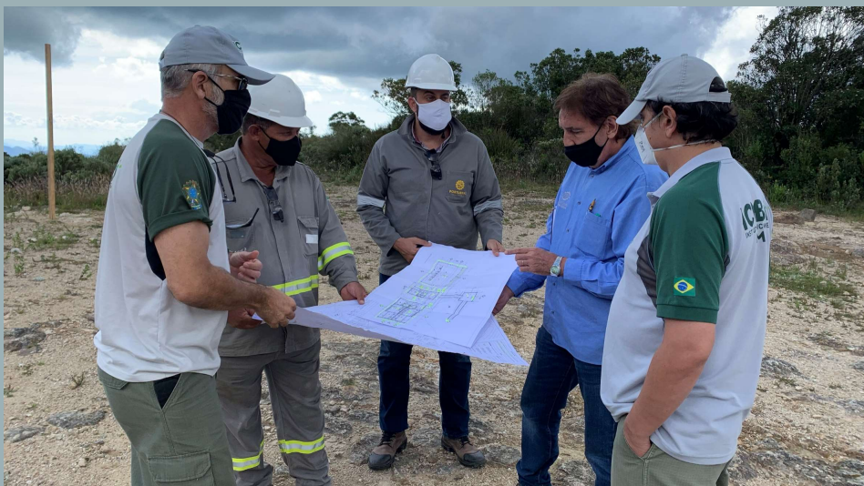
Equipe do PNI, juntamente com engenheiros da PORTUBRAS, verificam as obras.
