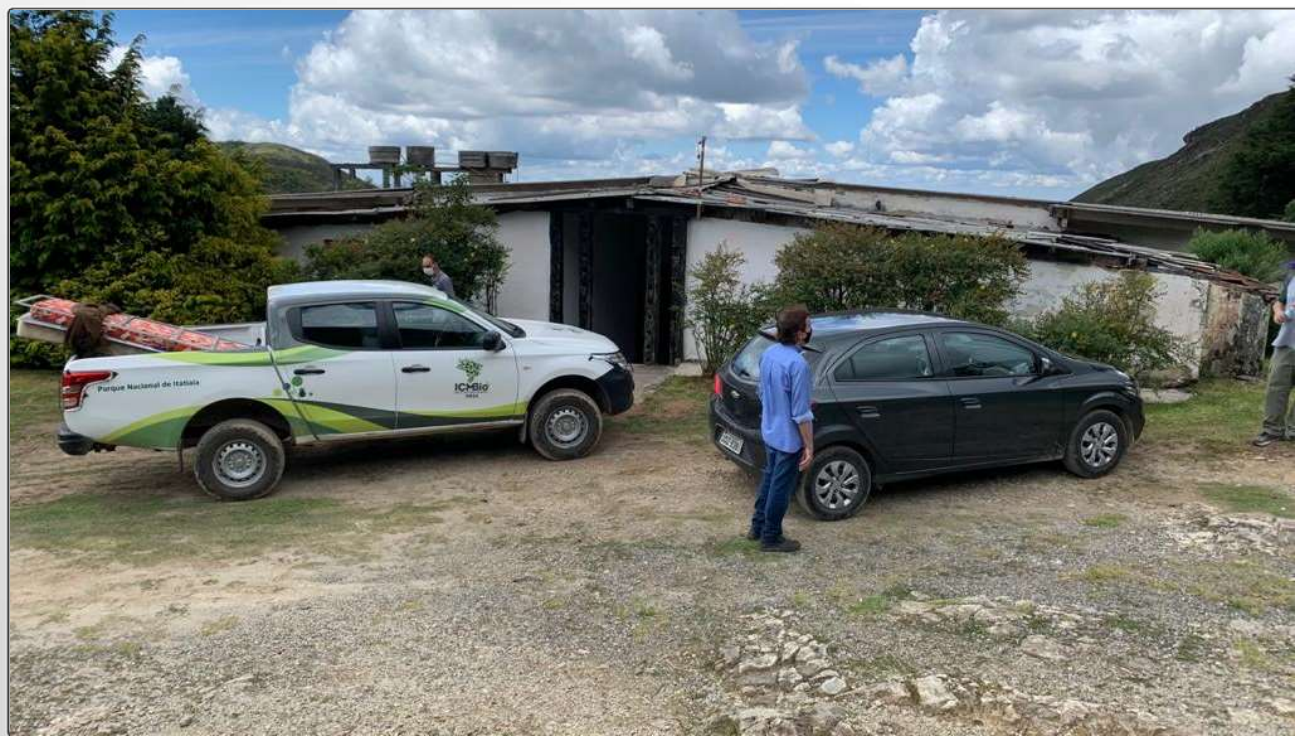
Antigo Hotel Alsene, agora canteiro de obras e alojamento da PORTUBRÁS.
