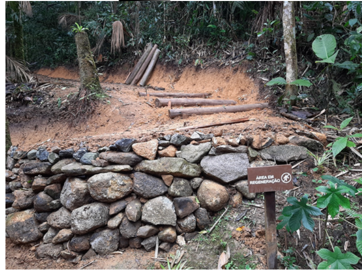
Contenção em rochas e facilitadores em eucalipto tratado
