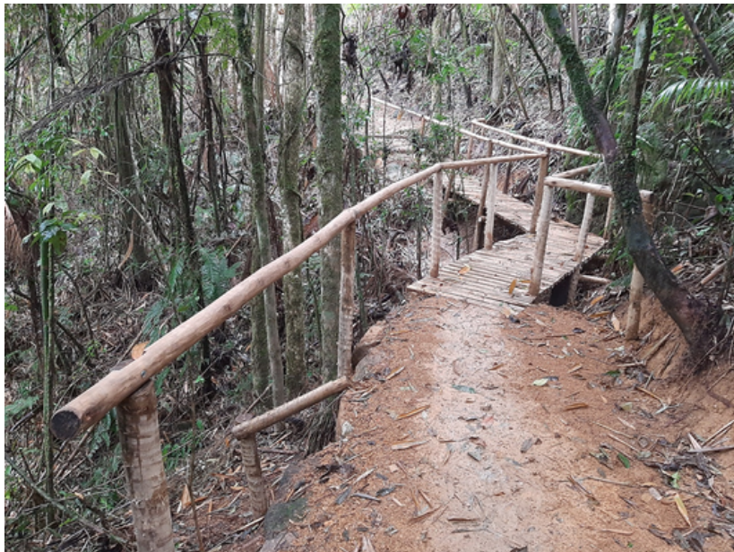
Passarela de eucalipto tratado em trecho do novo traçado
