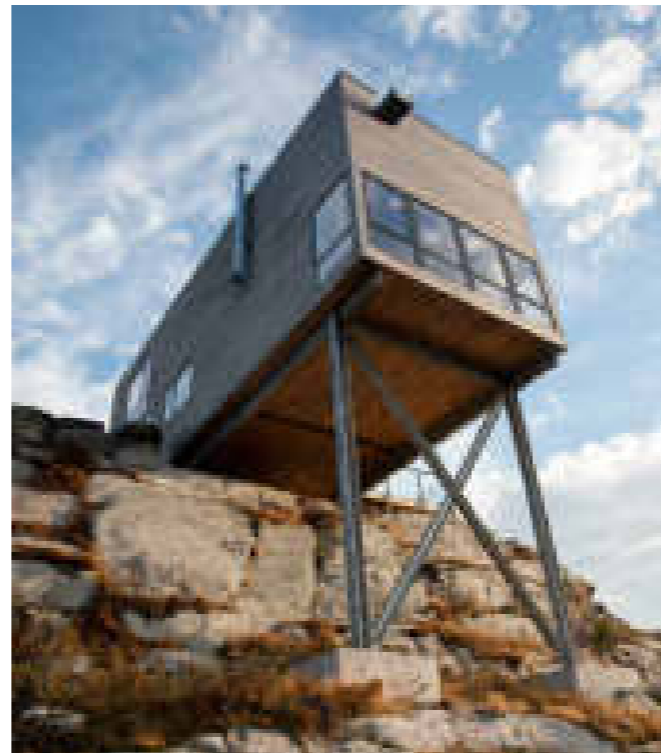
Edifício em estrutura metálica independente Fonte: https://www.dezeen.com/2013/11/18/cliff-house-mackay-lyons-sweetapple-architects/
