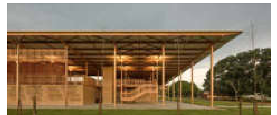
Moradias infantis_Fundação Bradesco com estrutura em madeira laminada colada. Fonte: ITA Construtora
