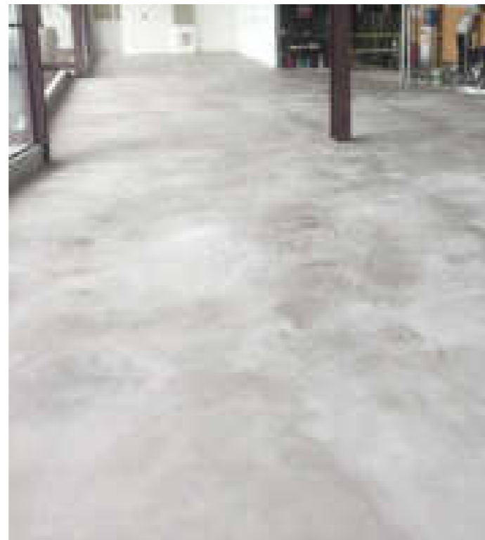
Piso em cimento queimado
