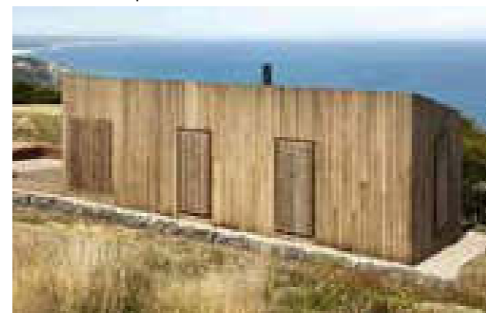
Edificação em estrutura de wood frame com acabamento externo com placas de madeira.
