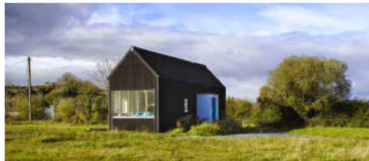
Edificação em wood frame Fonte: http://www.dominicstevensarchitect.net/#/25k-house-prototype/
