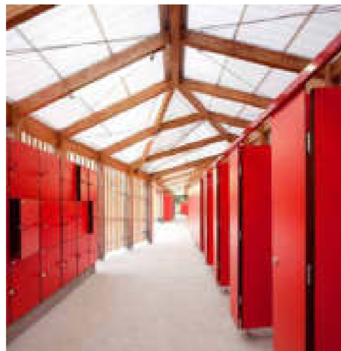
Divisórias em laminado compacto, robusto e autoportante
