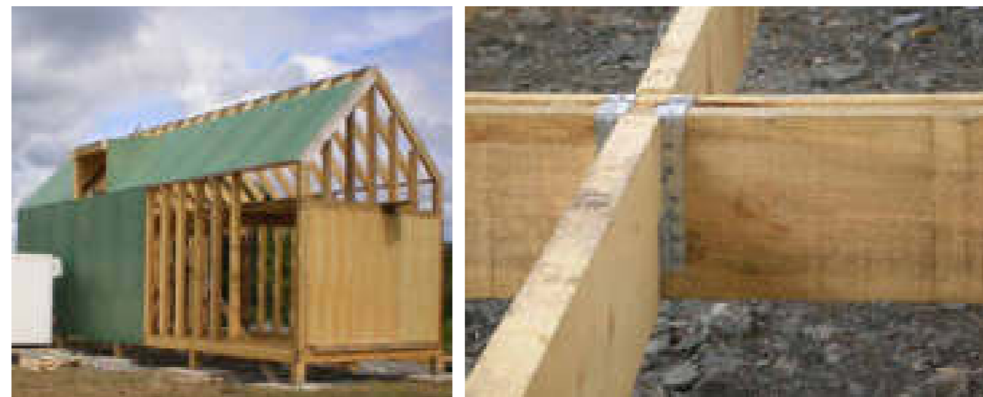
Montagem e obra de edificações com o sistema wood frame. Um dos benefícios do sistema é a facilidade da montagem. Fonte: https://www.irishvernacular.com/construction-photos.html
