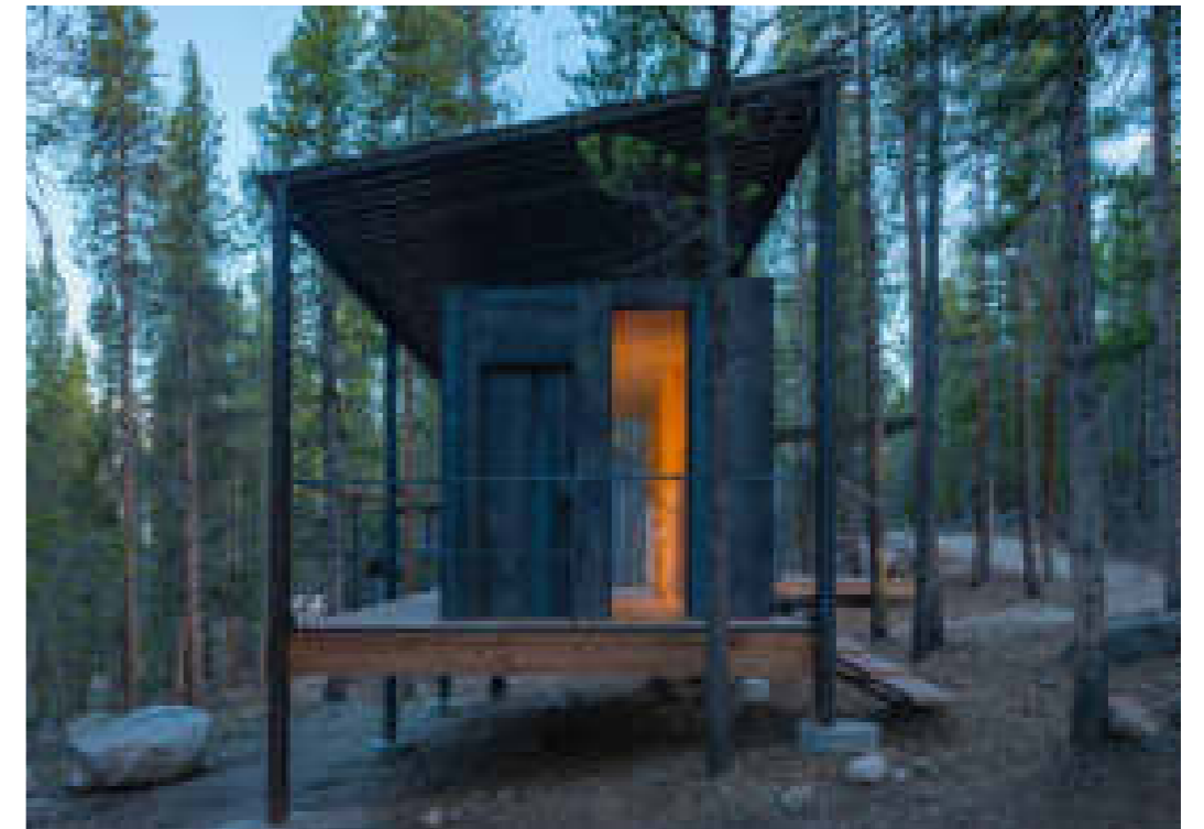
Edifício em estrutura metálica independente Fonte: https://www.archdaily.com/785103/colorado-outward-bound-micro-cabins-university-of-colorado-denver
