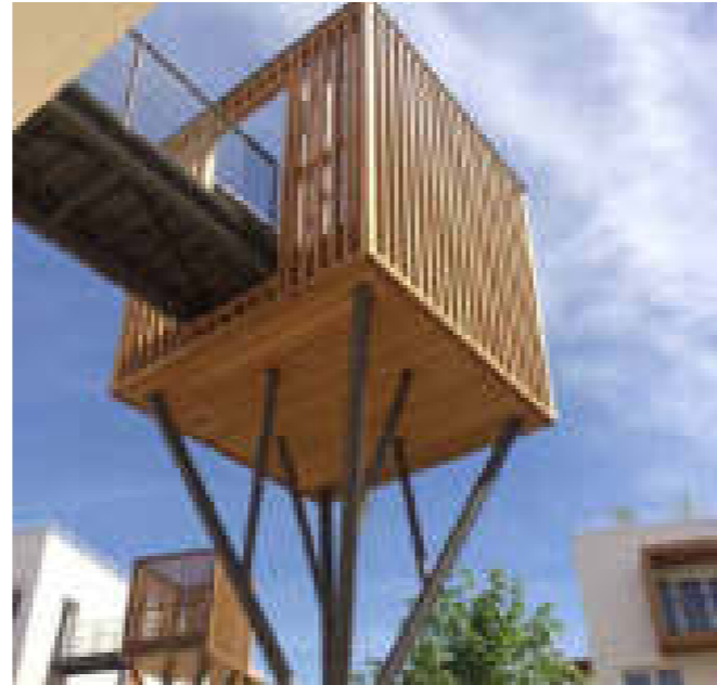
Pilares e passarela em estrutura metálica Fonte: http://www.viviengimenezarchitecture.com/
