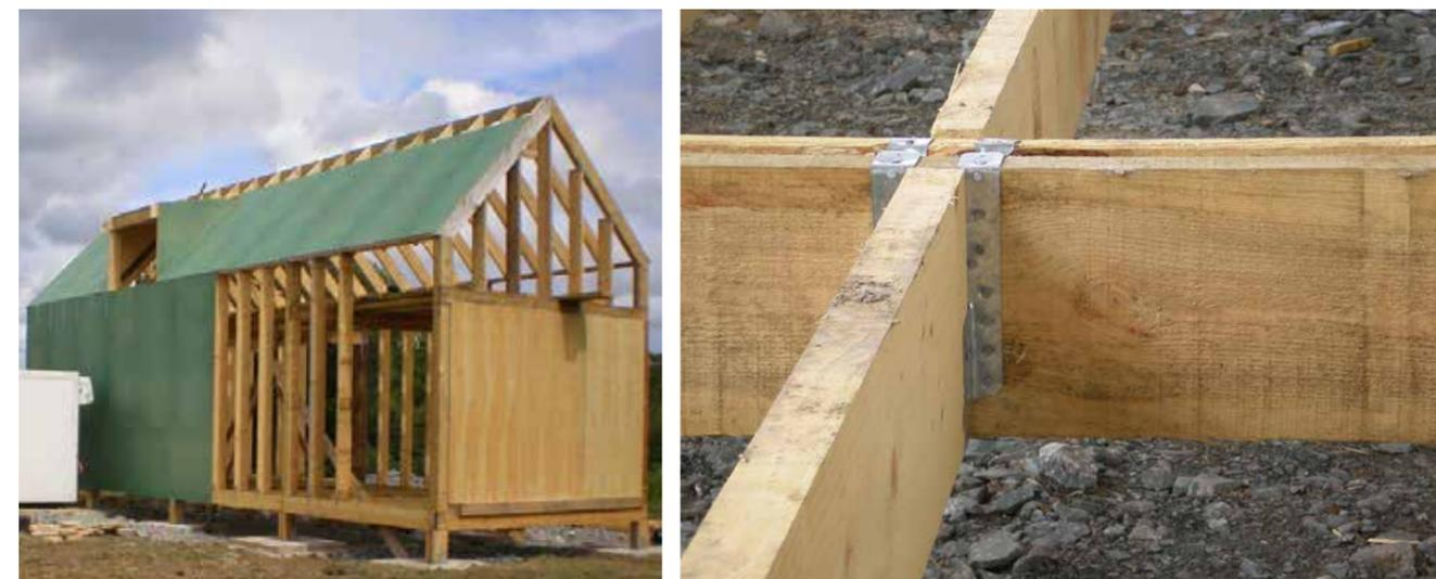
Montagem e obra de edificações com o sistema wood frame. Um dos benefícios do sistema é a facilidade da montagem.
