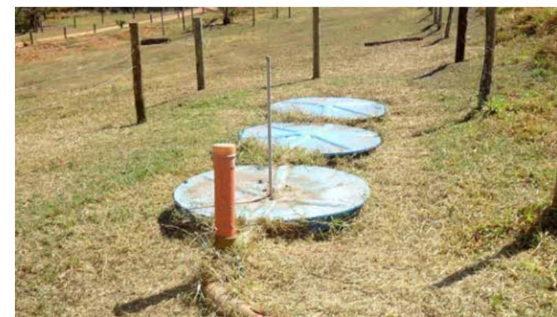
Exemplo de biodigestor
