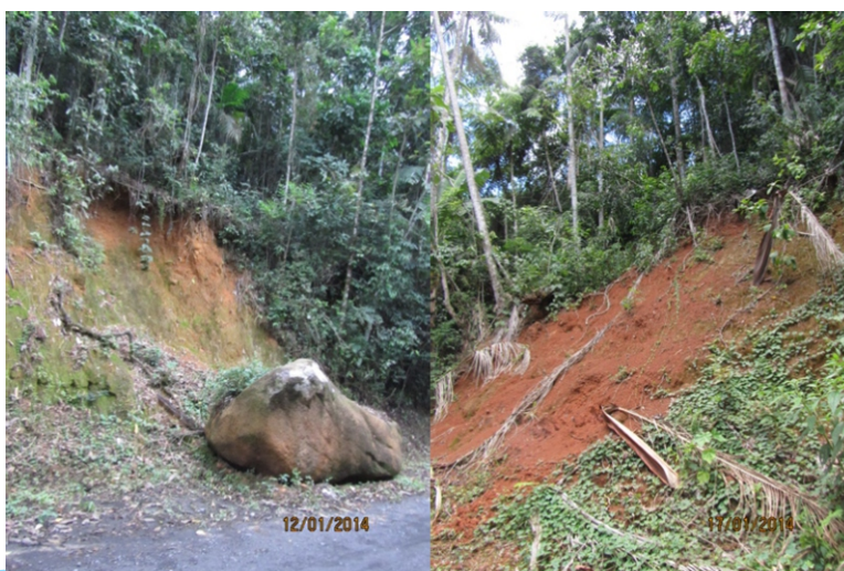
Figura 3 – Pontos de erosão na estrada. Fotos: - Nair D. P. Baumgratz.
